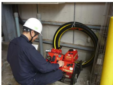
動力消火用ポンプ及びホースの点検整備
