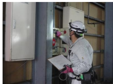
専門業者による消火器・火災報知器等の動作確認
