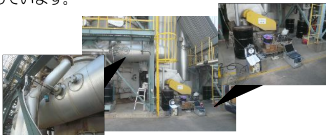
→排ガス測定の様子 (左：排ガス測定口 右：排ガス測定機器装置)
