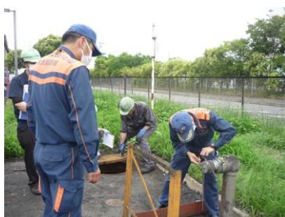
防火水槽内の水量および採水口の確認を行っています。
