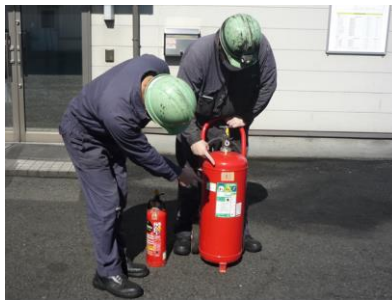
消火器の設置位置および使用方法等の確認を行い、緊急時対応訓練を実施しています。
