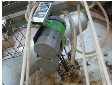
排ガスの成分を測定します。
