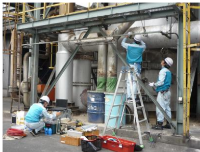
排ガス測定装置の設置・調整作業の様子。
