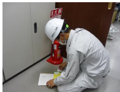
消火器の状態・使用期限等を 点検して頂いています。
