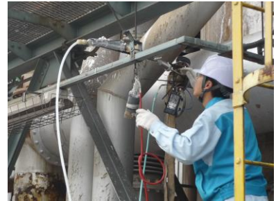
測定機器の設置および調整を行っている様子。
