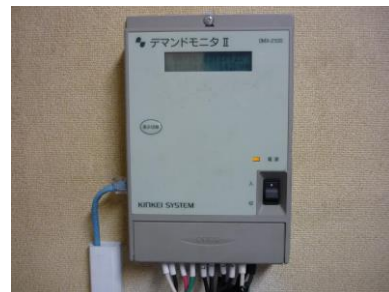
デマンドモニタ。社内LANに接続して電力を監視します。
