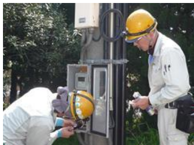
監視システム設置のための配線工事をしている様子。
